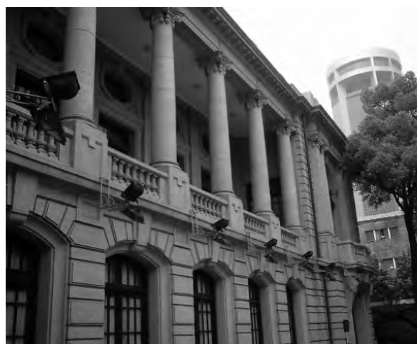
同東側旧エントランス部分
