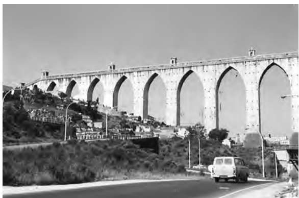
リスボンの水道橋
