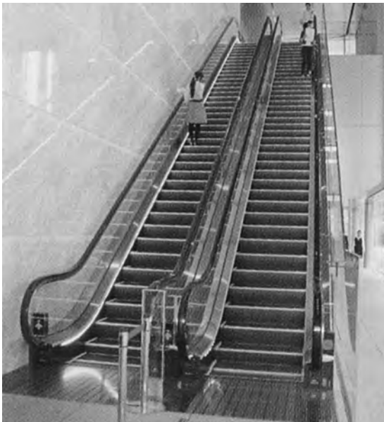
ビル正面入口から受付フロアまでの 直通エスカレーター
